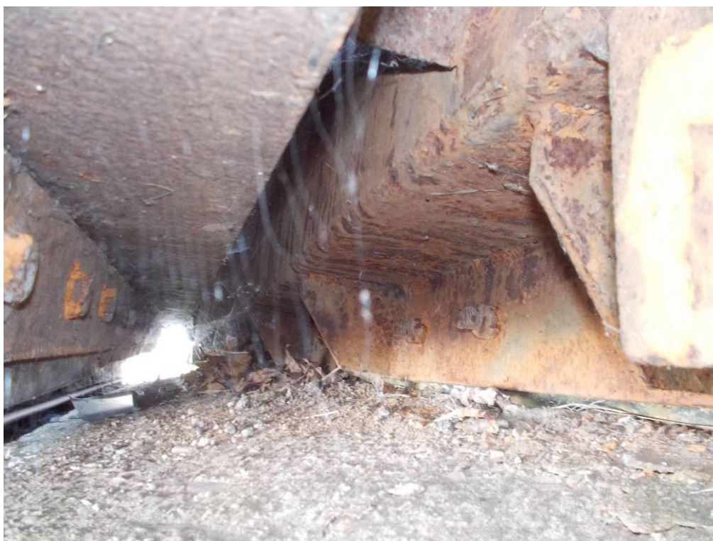
Detail dosedacího těsnění a prahu desek
