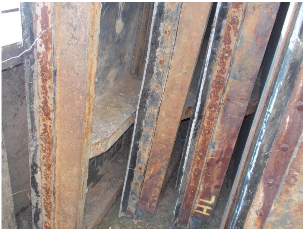
Detail bočního těsnění desek
